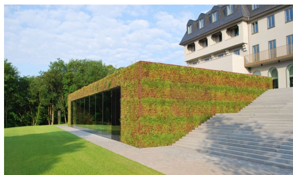
Abbildung 10 - Wandgebundene Fassadenbegrünung, Bildquelle: Optigrün.
