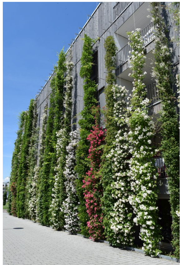
Abbildung 8 - Begrünte Fassade in Freiburg-Vauban, BuGG Bundesverband GebäudeGrün e. V.
